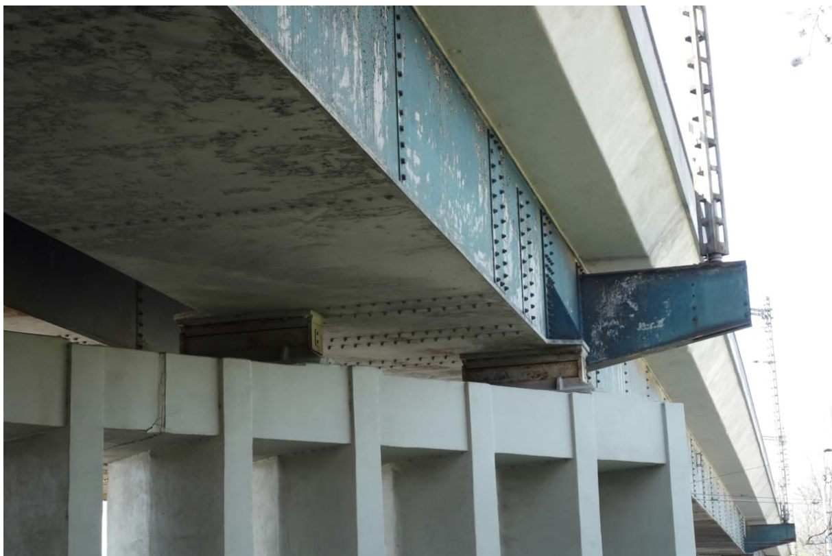
Obrázek 15 Pohled na uložení hlavní nosné konstrukce na pilířích mostu přes Olomouckou ulici, km 3,962.
